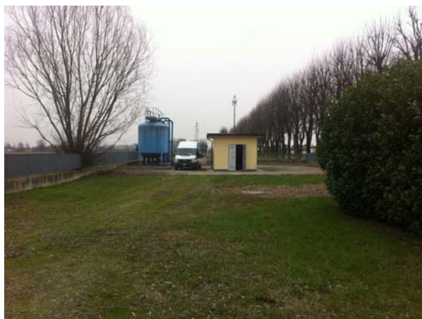
Area pertinenza pozzi
